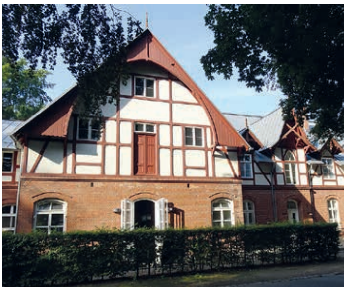
Die restaurierte ehemalige Polizeireiterunterkunft im Falkenstein
