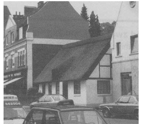
Das kleine Haus Nienstedtener Straße 1 vor dem Brand
