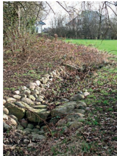
Bild 6. Um der Bek wenigstens zeitweise etwas mehr Wasser zu geben, kam man auf die Idee, sie über einen künstlichen Bergbach mit den Abflüssen von den Dächern und Straßen der neuen Wohnsiedlung „Am Westerpark“ zu speisen, und dieses Regenwasser dadurch vor der Kanalisation zu bewahren. Umweltfreundlich gedacht, aber und wenig effektiv und landschaftsfremd (wie allerdings auch der Wasserfall des Barons).
