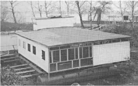
Bild 8. Bau der Kajüt 2. Dahinter das Küchenschiff.
