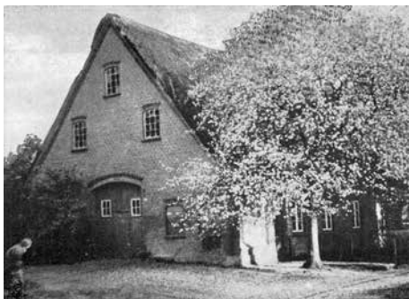
Bild 2. Der markante Giebel der alten Kate am Schulkamp vor dem Abriss 1960.
