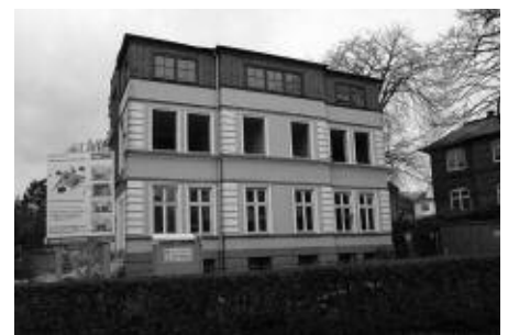
Bäume, Pflanzen und Fenster sind schon entfernt
