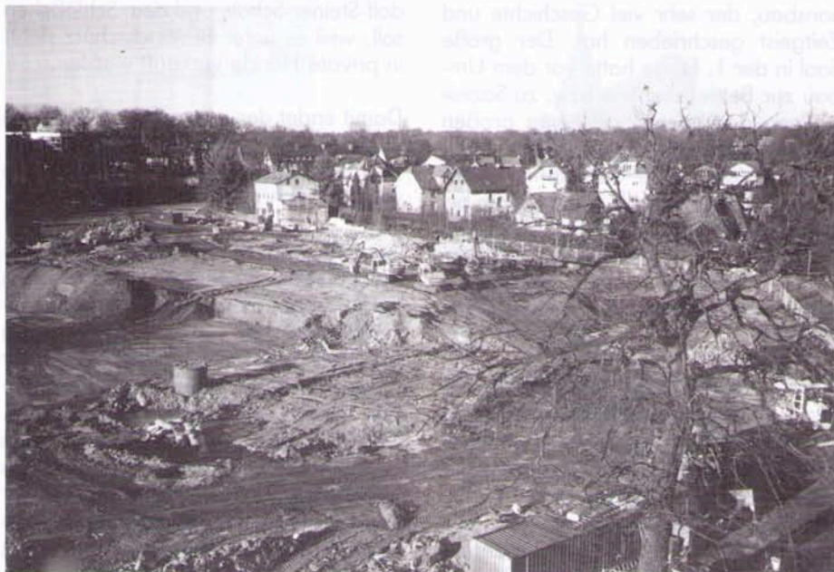
Bild 1: Öd und leer nach den Abbrucharbeiten
