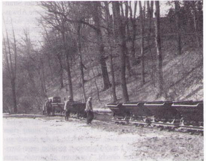
Feldbahnzug aus Diesellok und Kipploren.
