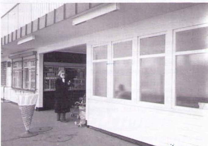
Die Wartehalle auf dem östlichen Ponton des Anlegers Teufelsbrück hat eine elbseitige Glasverkleidung erhalten. Aus Sicher-
