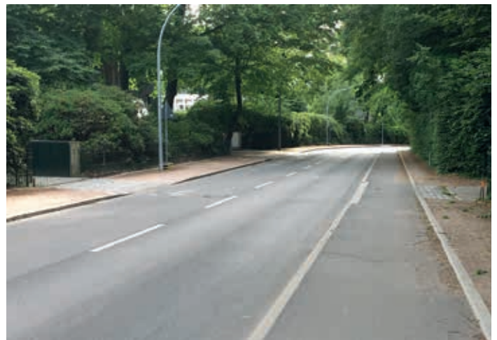
Optische Teilung des Straßenraums durch neuen Radweg (1. Bauabschnitt) Beton versus Granit
