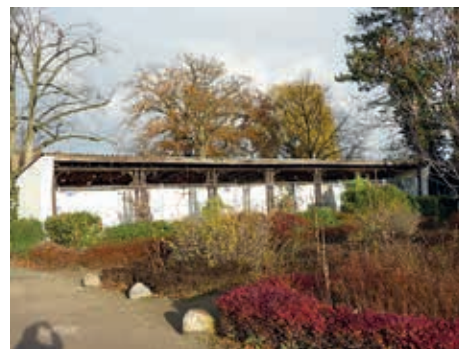
Jenischpark , Eingang Hochrad: Wiederherstellung der Pergola
