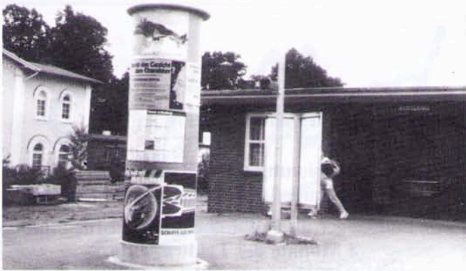
Der Ausgang vom Bahnsteig aus. Der Empfangs- und alte Schalterraum nebst Gepäckaufgabe (seit Jahren stillgelegt) wird abgerissen, wird westliche Bahnsteigverlängerung, überdacht in vorh. historischer Formgebung, Zughalt wird in Richtung Blankenese vorverlegt. Diese Aufnahme ist nun historisch (1. 9. 89).
