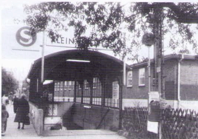
Treppenüberdachung an der Ohnhorststraße, wird renoviert; ähnlich soll die Überdachung für die Treppe auf dem ehem. Güterbahnhofsgebäude werden. Hinter diesen Treppenabgang soll nach Osten eine behindertengerechte Rampe parallel zu Straße und Gleis gebaut werden.
