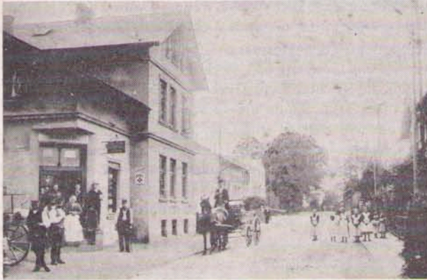
Das Geschäft „Schultz“ (damals Wilhelm Blöcker) um 1900 in der Mittelstraße — auf dem Kutschbock: Ww. Blöcker
