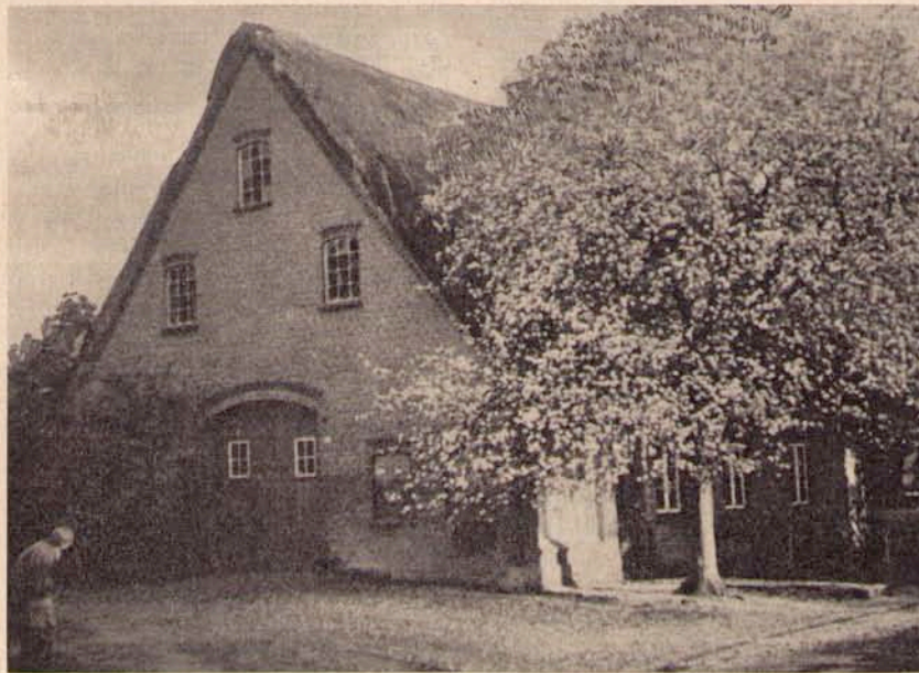
Das alte ehemalige Felst'sche Bauernhaus
